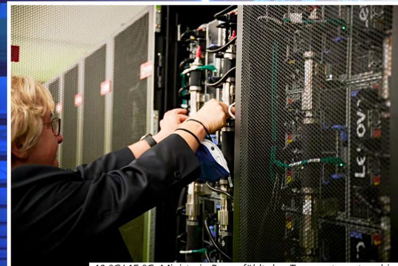
40 °C/45 °C: Ministerin Bauer fühlt den Temperaturunterschied des Kühlwassers bei Ein- und Austritt in den Cluster.
