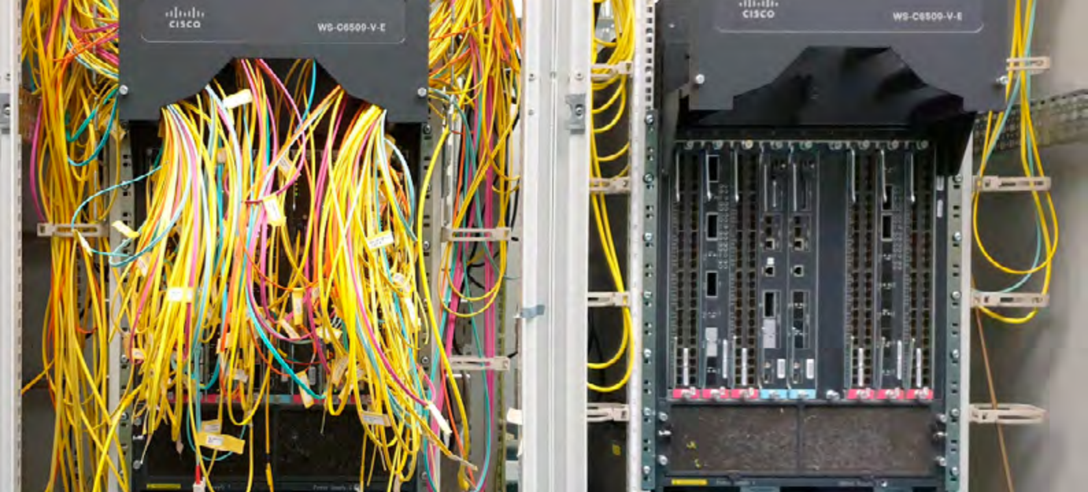
Abbildung 2: Kürzlich abgeschalteter Router neben einem noch laufenden Router des alten KIT-Backbones.
